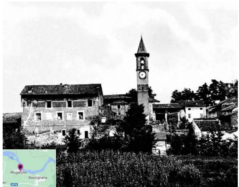
Mugarone. Ruederi della rocca di origine longobarda e delle mura che circondavano il centro storico del paese, Torre del castello trasformata in campanile
